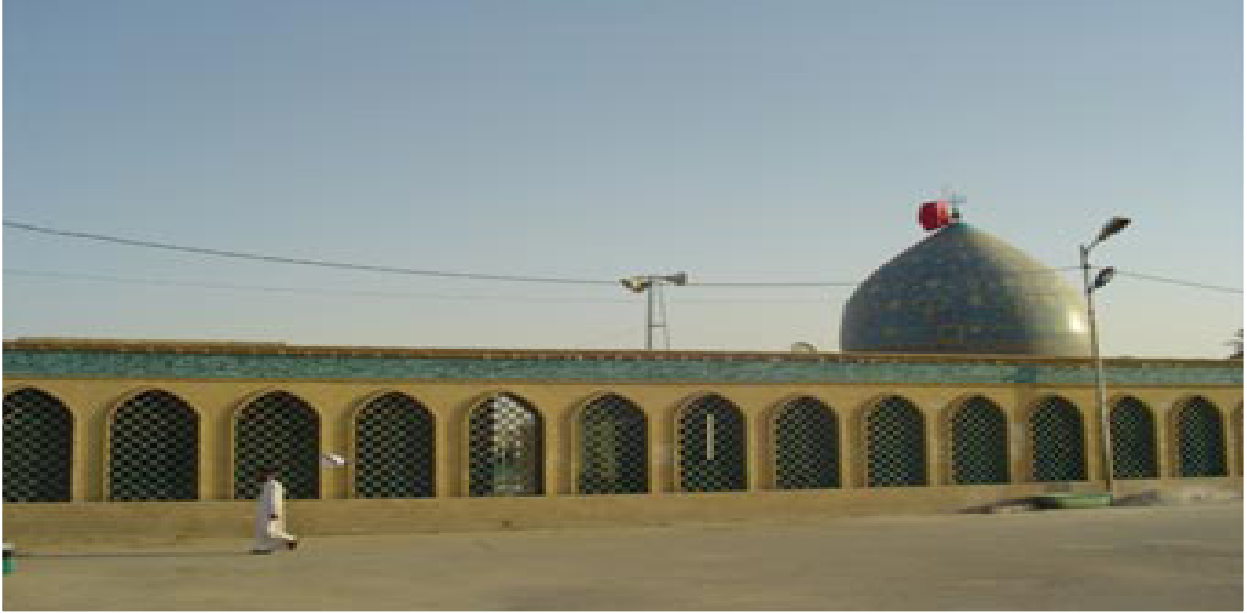
الصورة (٢) المظهر الخارجي للسياح الخارجي
